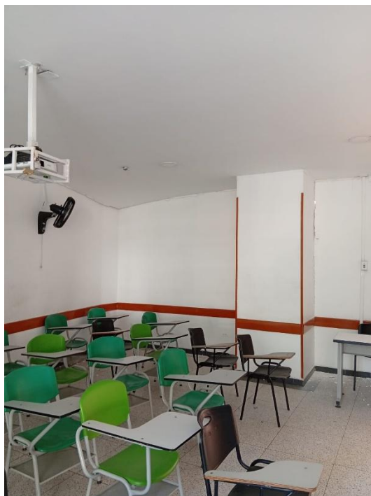
Ilustración 10. Columna segundo piso
