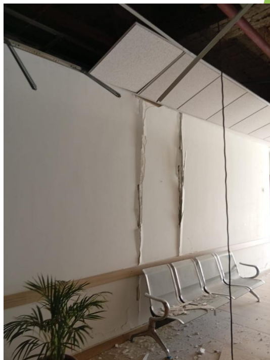
Ilustración 16. Columnas en piso 3 (evidencia de interacción con muro divisorio)
