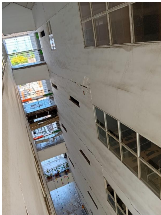
Ilustración 31. Vigas de entrepiso vista de 5to piso
