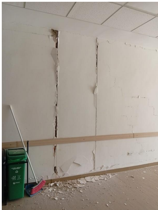
Ilustración 21. Columnas en piso 4
