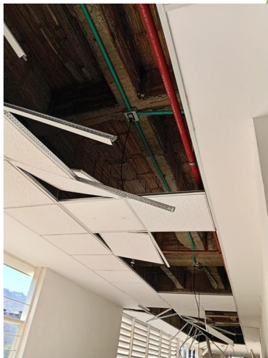
Ilustración 19. Placa de entrepiso piso 3
