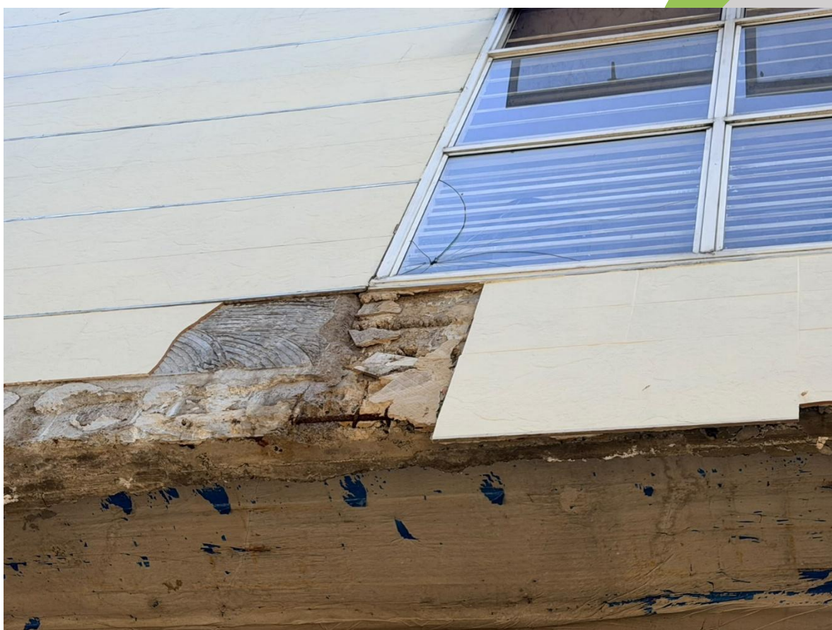
Ilustración 9. Losa de entrepiso piso 1 INTENALCO 10-08-2026
