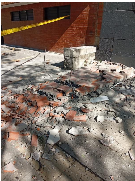
Ilustración 36. Mampostería volcada - INTENALCO -10-08-2026
